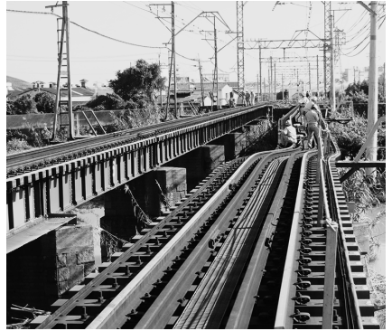
台風21号で洗掘され歪んだ鉄橋
