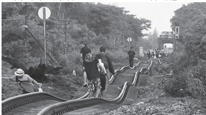
昨年の洪水で破壊されたバンコクマレーシア間の鉄道（筆者）
