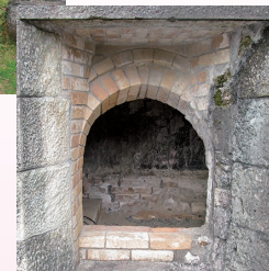
反射炉の内部。ドーム状なのが分かる
